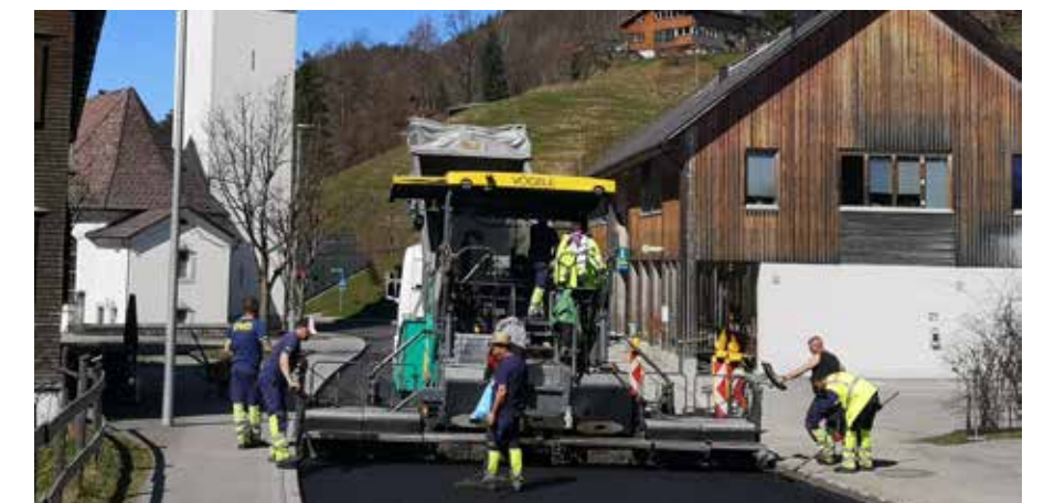
Straßensanierung L28 - Asphaltierung
